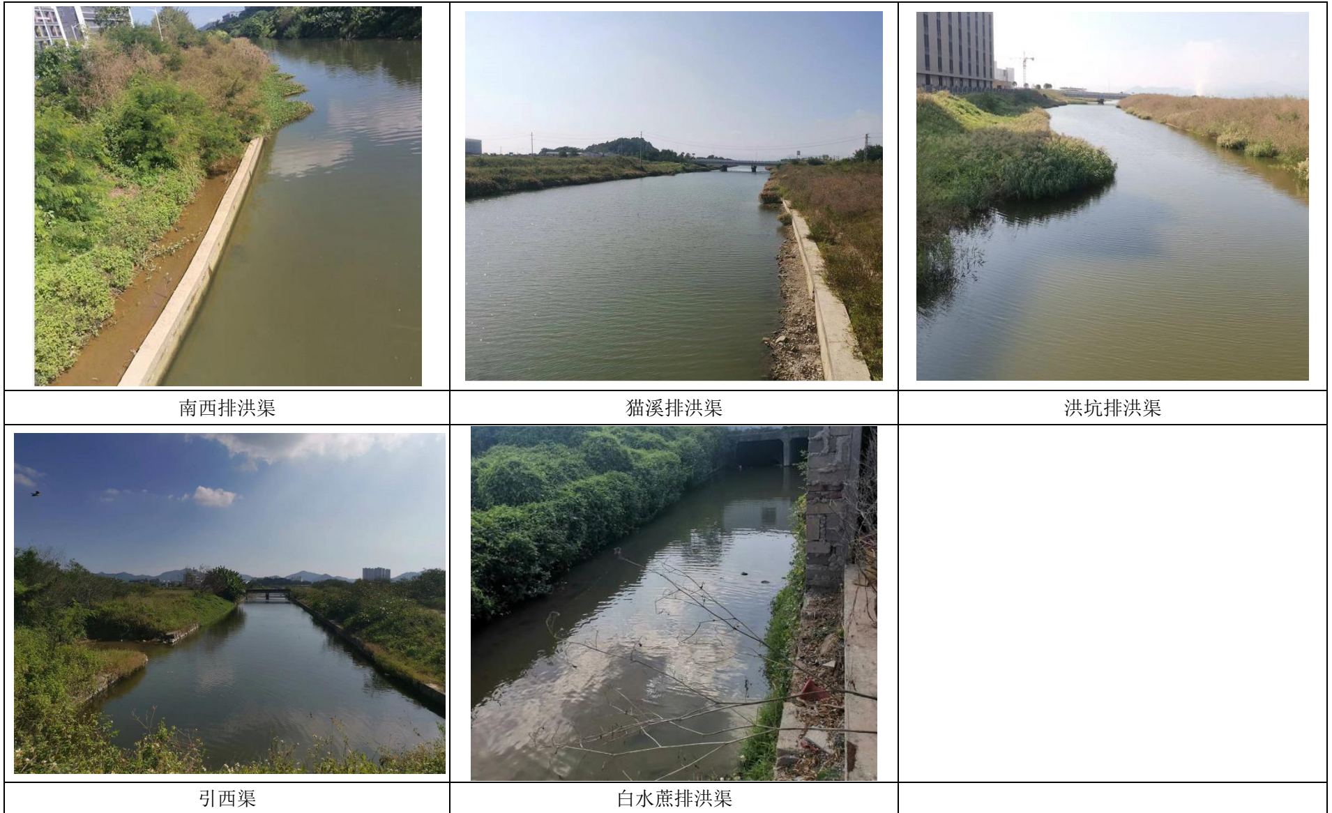
附图 6 项目工程改建后现场图
